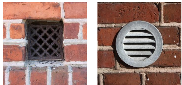
▼ Friskluftventiler har man kendt til længe: Til venstre rist fra ca. 1875, der skulle ventilere bjælkelaget. Til højre en moderne ventil i galvaniseret stål.
