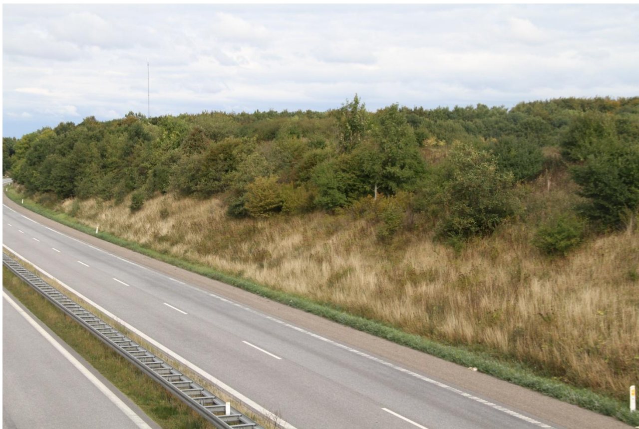
Lok. 15: Sydmotorvej, Kulsbjerg, nord for afkørsel mod Vordingborg
