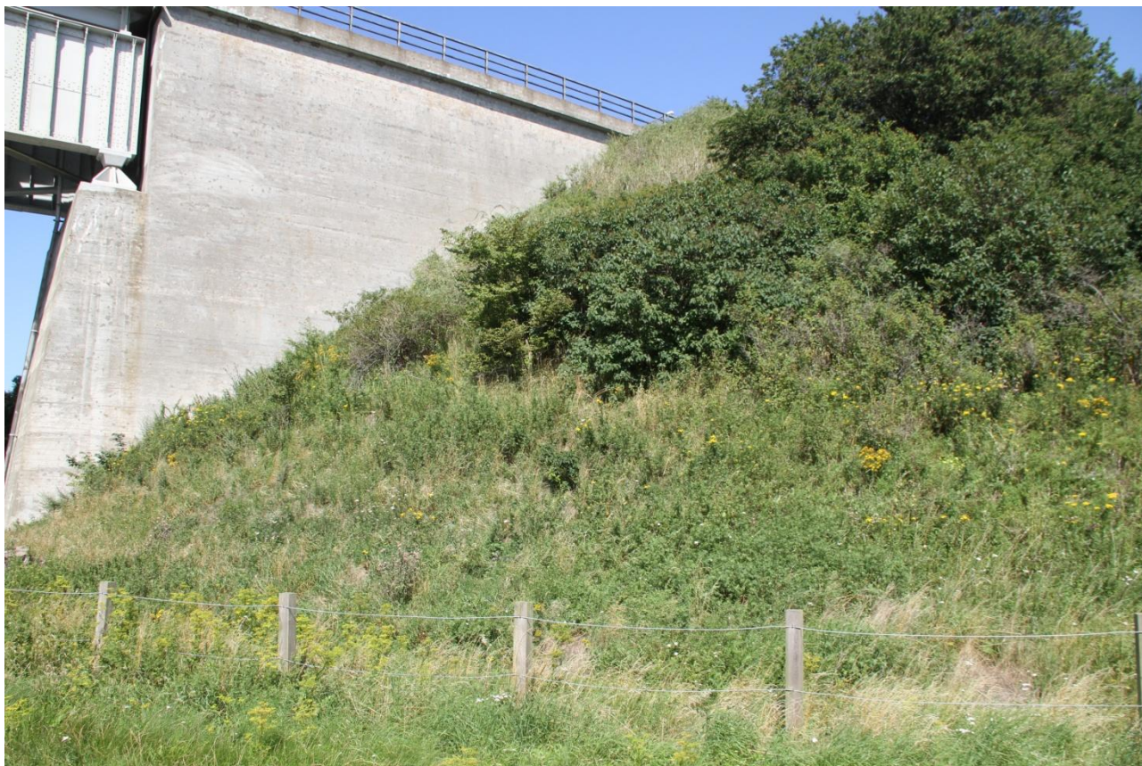
Lok. 25: Masnedø, syd, jernbanedæmning ved Storstrømsbro.
