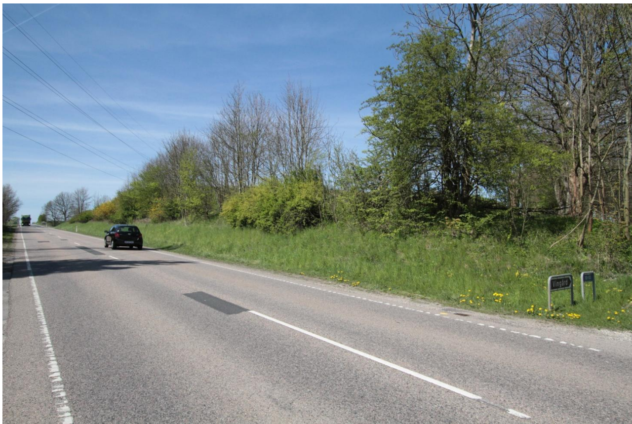
Lok. 4: Vejskråning ved Risby, Næstvedvej
