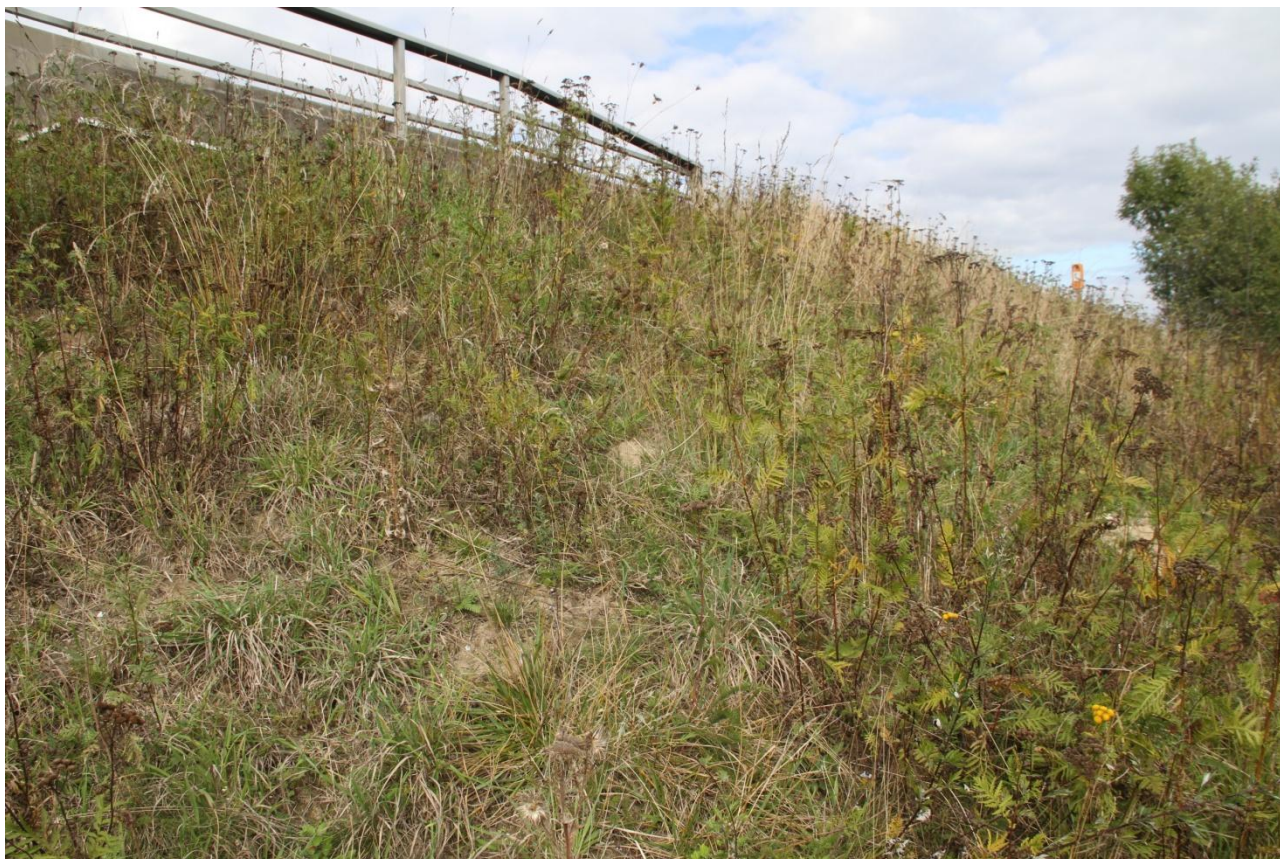
Lok. 14: Mønsvej/Nyråd ved brooverførsel motorvej
