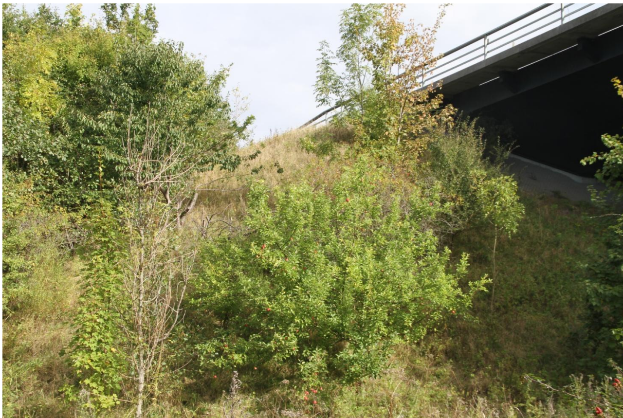
Lok. 17: Bakkebølle ved Farøbro
