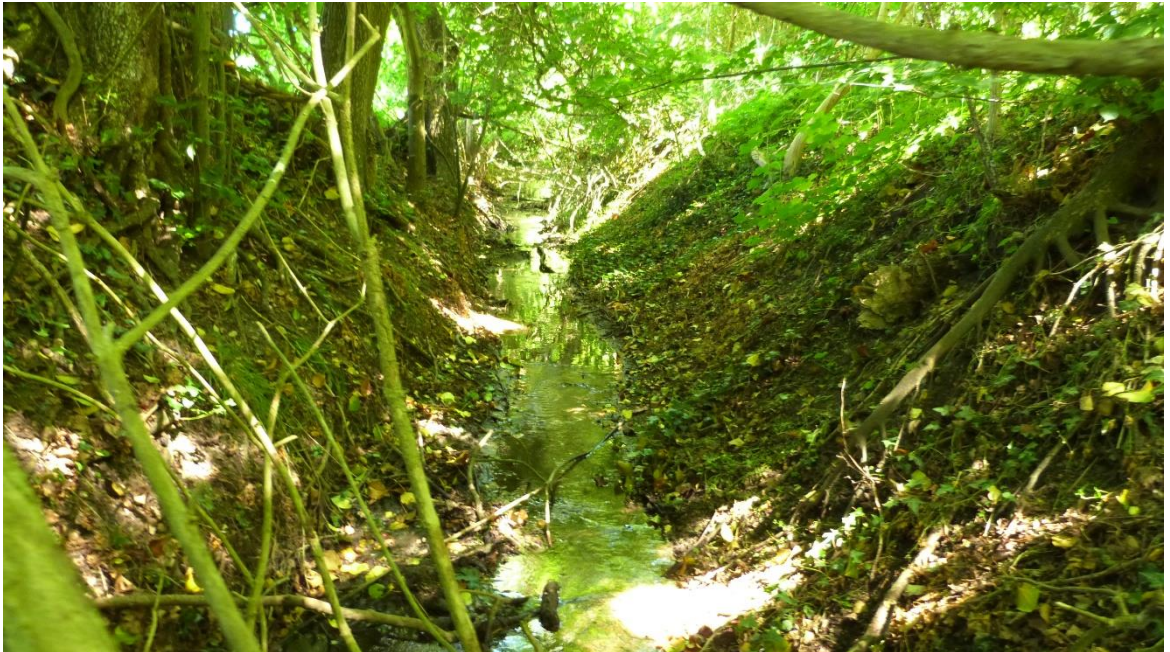
Figur 7-4. Den nederste strækning af det private vandløb er dybt nedskåret, med et rimeligt fald, og med groft materiale i vandløbet. Bundbredde ca. 60 cm.
