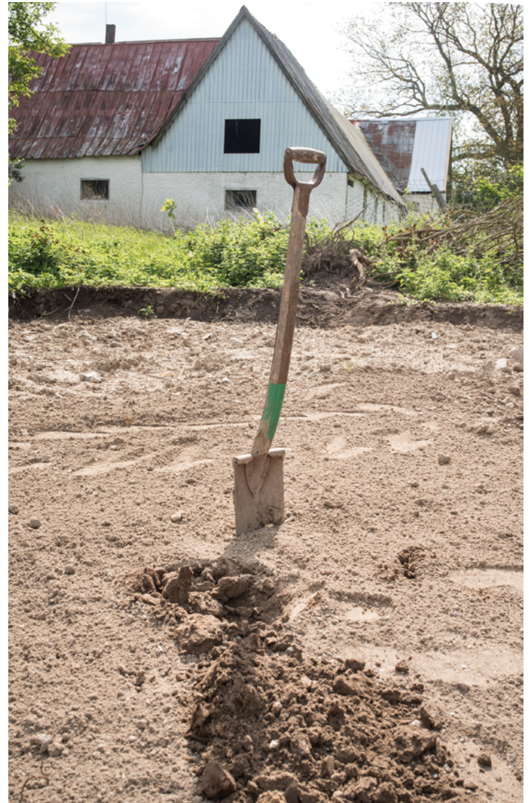
Første spadestik, forandringsprojekt på 44Møen i Askeby, maj 2022. Spaden er en del af Henning Christiansens værk Haveorkestret. Foto: Thomas Gunnar Bagge.
