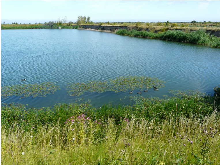
Bassin 12, set fra syd, Digesvaleskrænten til højre, 2008.
