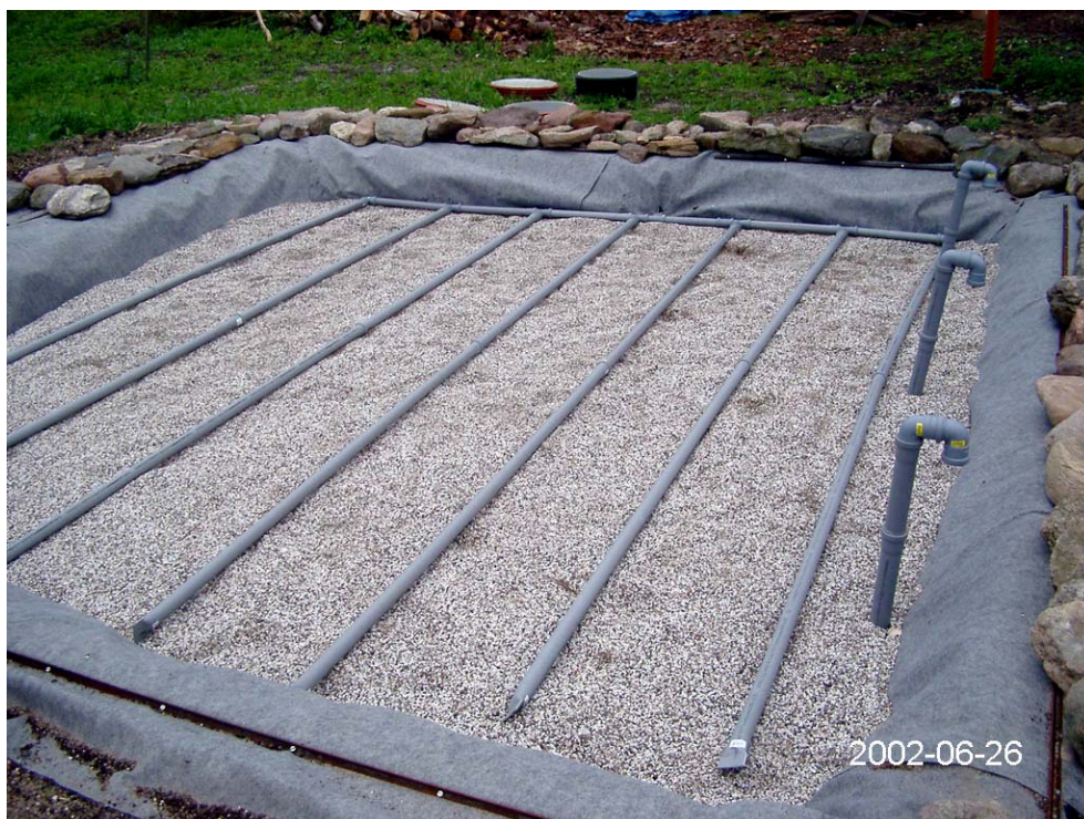
Figur 6.4 Trykfordelerrør placeres vandret på overfladen af filtersandet. Til højre ses udluftningsrørene fra drænene, der er ført ca. 0,3 m op over anlægget endelige overflade.
