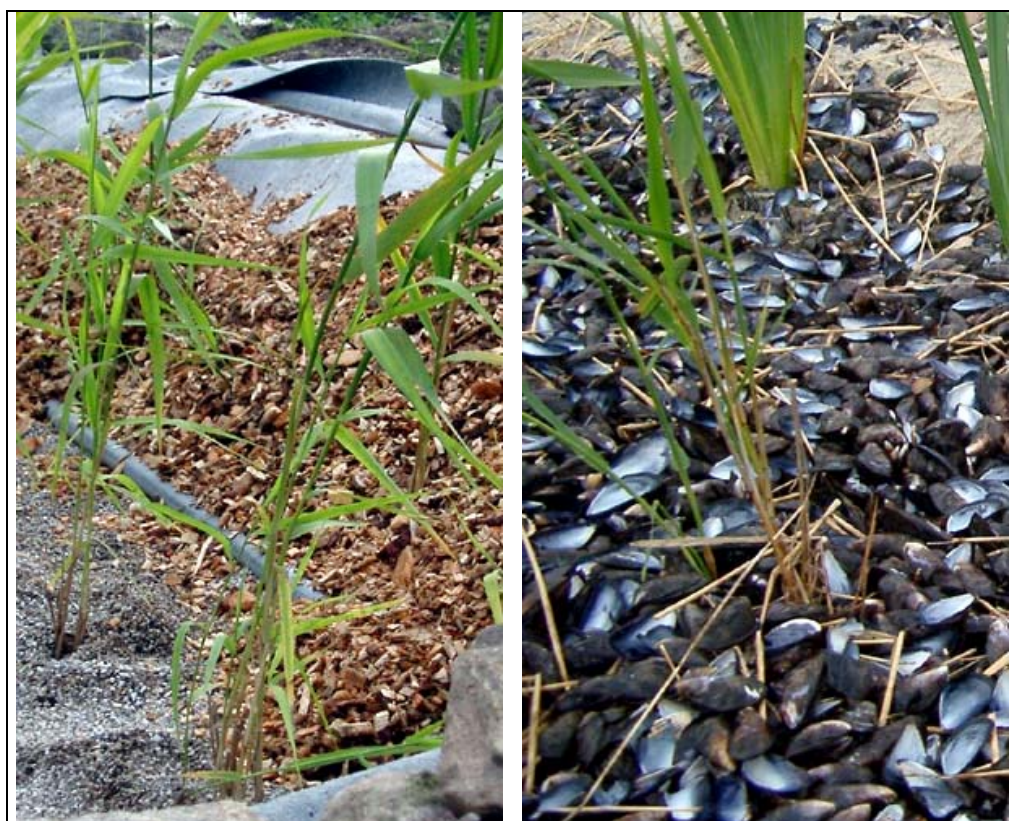
Figur 6.12 Udlægnings af træflis (til venstre) eller muslingeskaller (til højre) som isolering på overfladen af filteranlægget
